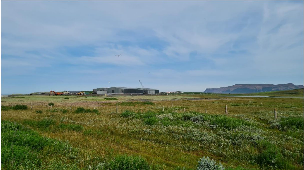
MYND 4.18 Myndatökustaður 2. Mannvirki í tengslum við framkvæmdina hafa verið varpað á myndina. Byggingarnar má sjá fyrir miðri mynd. Gögn: EFLA
