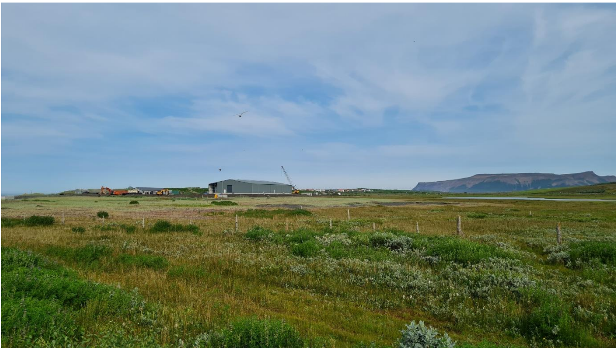
MYND 4.17 Myndatökustaður 2. Grunnástand. Myndin er tekin frá Sléttuvegi, horft er til norðvesturs. Fyrir miðri mynd má sjá fyrirhugað framkvæmdarsvæði og má meðal annars sjá í kerjapallinn sem þegar hefur verið reistur ásamt þjónustuhúsi. Mynd: EFLA
